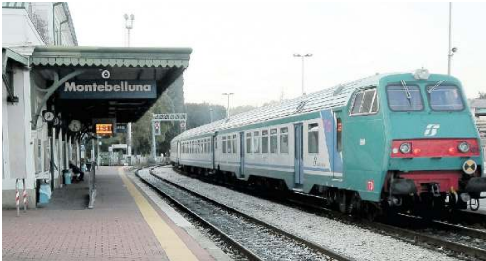
DISAGI TERMINATI A giorni, finiti i lavori di elettrificazione, i treni torneranno a correre sulla linea Castelfranco-Montebelluna-Feltre
